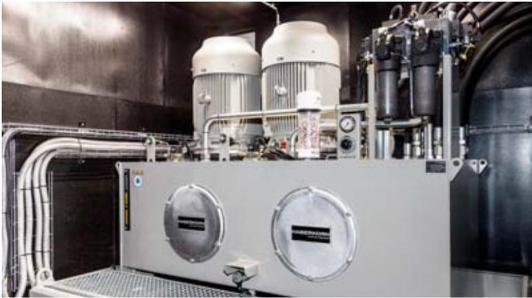
Eines der beiden Hydraulikaggregate für die Bewegung von Kopf und Hand der Bregenzer Seebühne: Sie sind mit jeweils zwei Antriebs-einheiten ausgestattet. Bild: Michael Pypser
