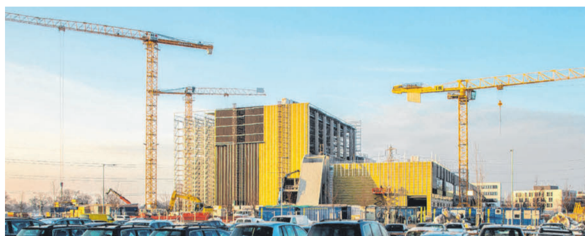
Der Erweiterungsbau liegt bezüglich Kosten und Fertigstellungstermin im Plan.
